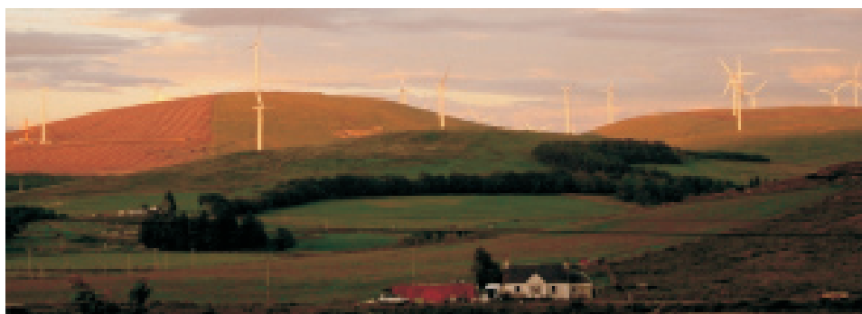
Fot. 2. Farma wiatrowa „Clyde”, odcinek E tuż po założeniu turbin, rejon Watermeetings koło Elvanfoot, South Lanarkshire, Szkocja.
