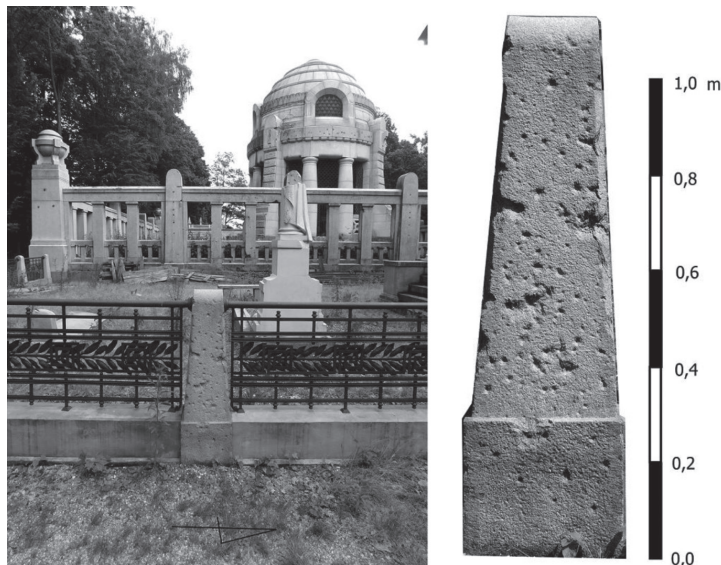
Ryc. 5. Ślady ostrzału na piaskowcowym słupku ogrodzenia otaczającego mauzoleum Silbersteinów. Fotografie i opracowanie własne.
