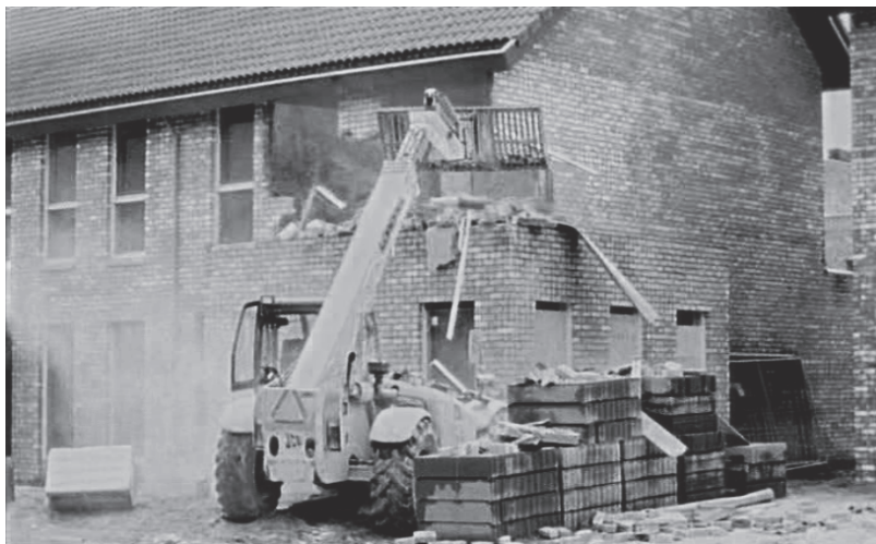
Fotografia 4. Polonez 8 : Maciek spychaczem niszczy swój „dom marzeń”.
