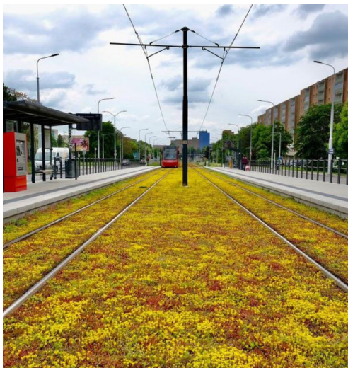
Rys. 4. Rozchodnik zamiast betonu na torze tramwajowym (fot. Marek Velček, Hlavné mesto Bratislava)
