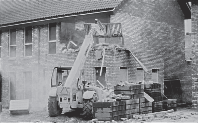
Fotografia 4. Polonez 8 : Maciek spychaczem niszczy swój „dom marzeń”.
