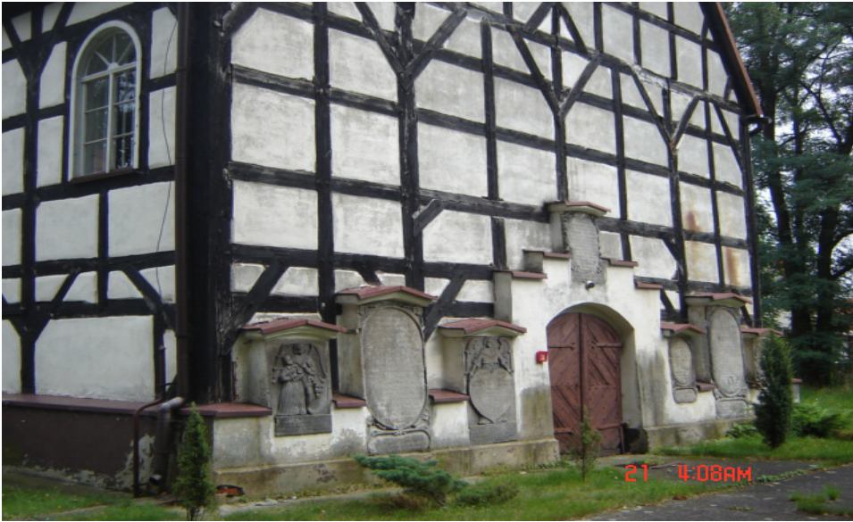
Fot. 1. Płyty nagrobne w licu kościoła pw. MB Różańcowej w Trzmielowie (woj. dolnośląskie). Pierwotnie ewangelicki kościół graniczny, wzniesiony w 1659 roku. Fot. Jacek Grzywa
