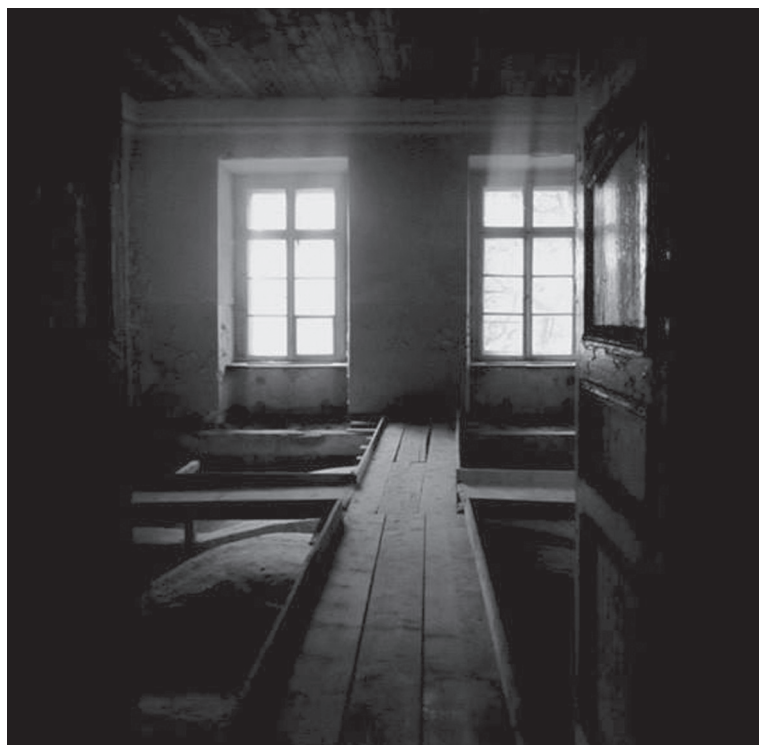
Fot. 10. Wnętrze pałacu w Pilicy (fot. M. Świerczek, 2013)
