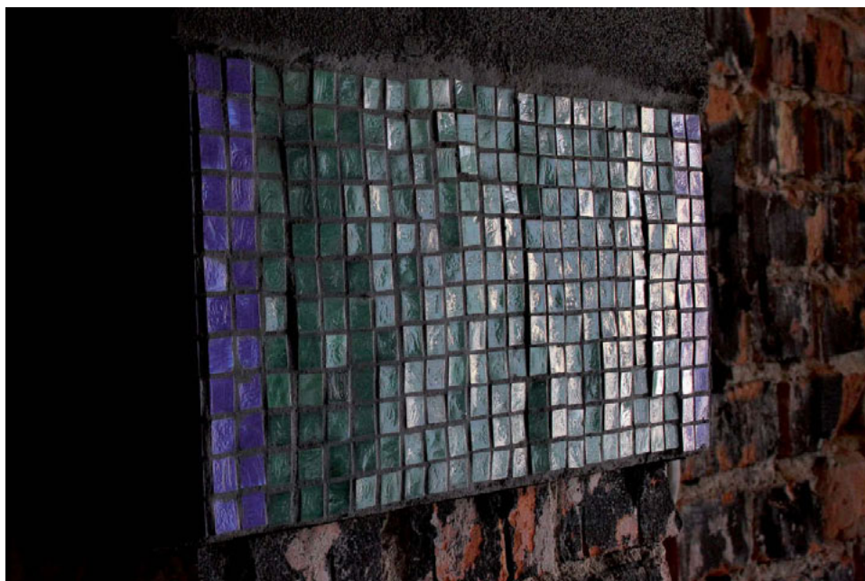
Fot. 5. Rekonstrukcja mozaik. Stan z 2012 roku. Fot. Tomasz Waszczuk
