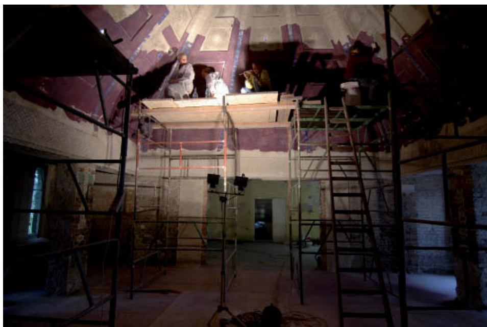
Fot. 2. Rekonstrukcja kopuły. Stan z 2007 roku. Fot. Jacek Sztorc
