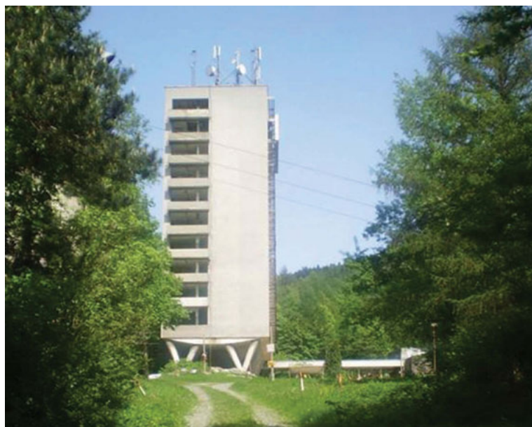
Fot. 8. Szpital Miejski „Stalownik” w Bielsku-Białej, widok na budynek sanatorium (fot. M. Talik, 2013)
