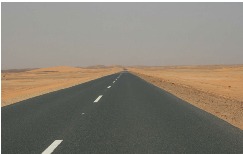
Fot. 4. Nowa, asfaltowa droga w pobliżu ed Ghaddar (fot. M. Kurcz 2013)
