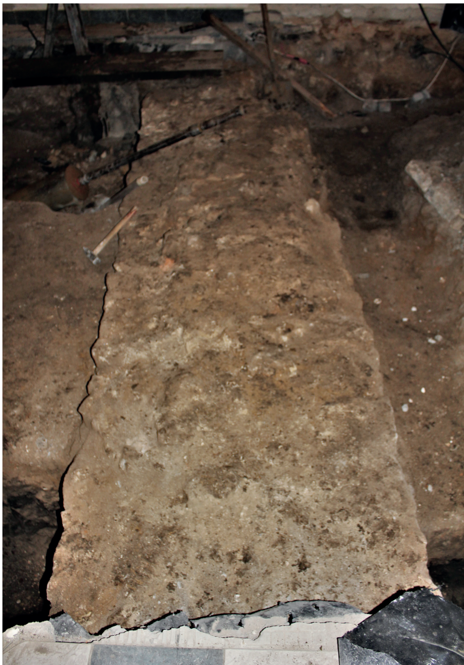
II. 4. Skuta korona kamiennego muru poprzecznego, fot. Monika Łyczak (2018).
