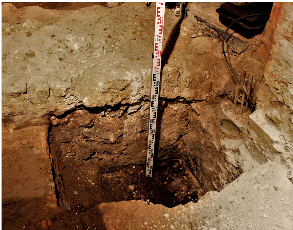
II. 5. Partia fundamentowa kamiennego muru poprzecznego, fot. Monika Łyczak (2018).
