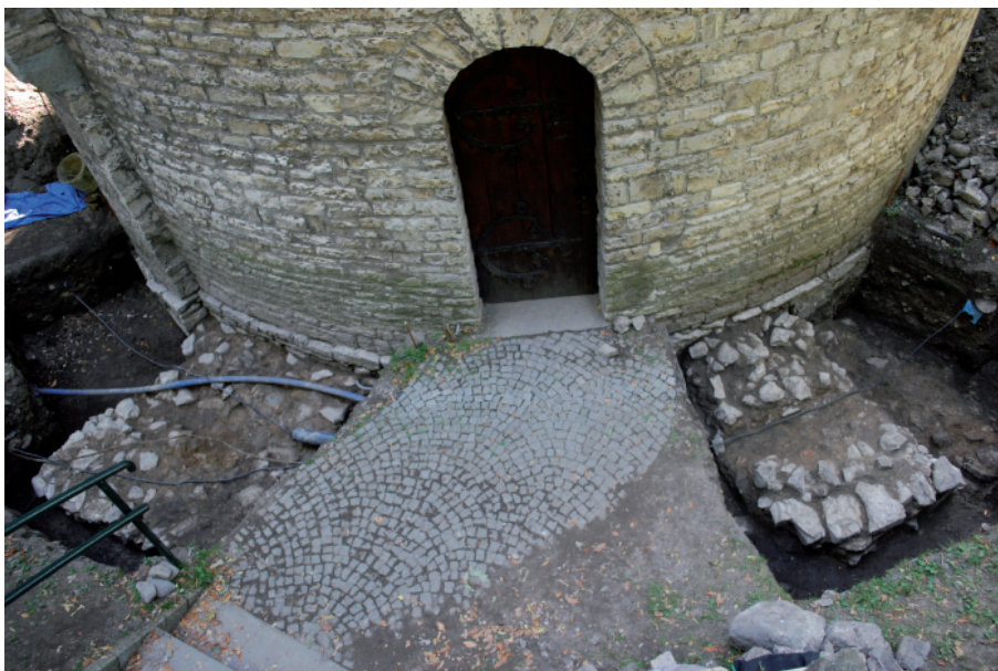
Il. 2. Obiekty – przypory nr 1 i 2 Fot. M. Piwko
