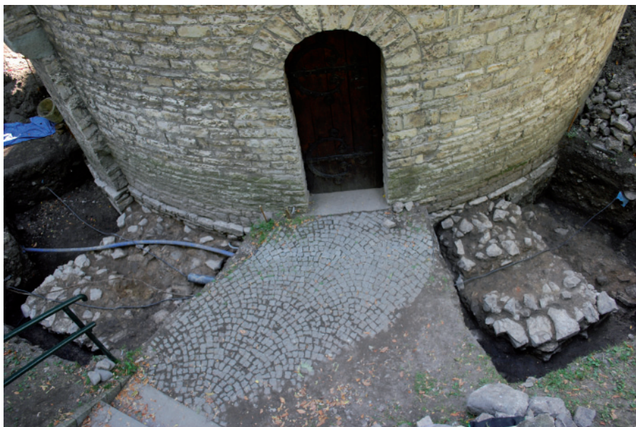
II. 2. Obiekty – przypory nr 1 i 2 Fot. M. Piwko
