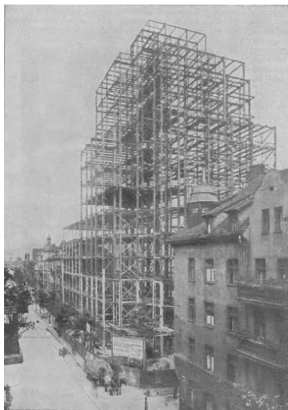
Fot. 7. Montaż konstrukcji stalowej (S. Bryła, H. Grieffel: Budowa... , s. 18)
