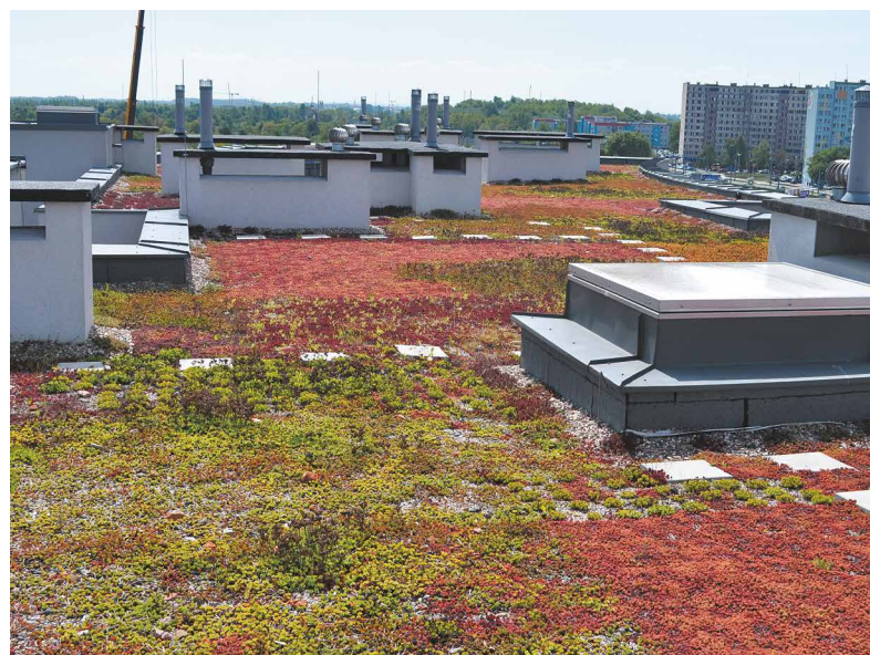
Dach rozchodnikowy na budynku wielomieszkaniowym we Wrocławiu, Polska / fot. Marta Weber-Siwińska
