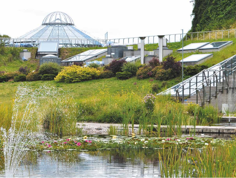
Dach Filharmonii Podlaskiej w Białymstoku / fot. Marta Weber-Siwińska
