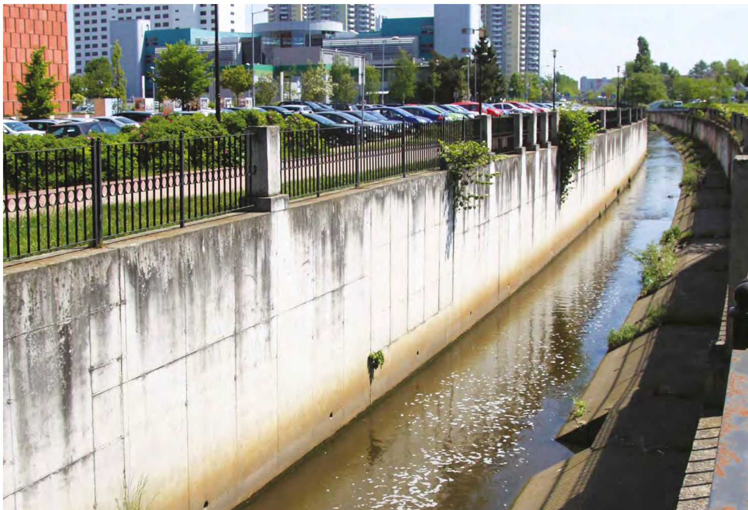
Zabetonowane koryto Rawy w Katowicach / fot. Agnieszka Sikora
